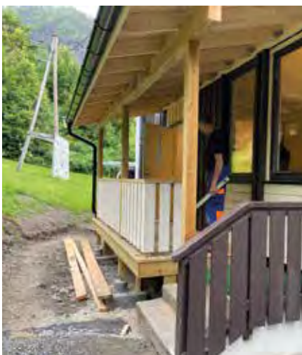
Byggeperiode: nytt, overbygd inngangsparti på baksida av skulebygget.
