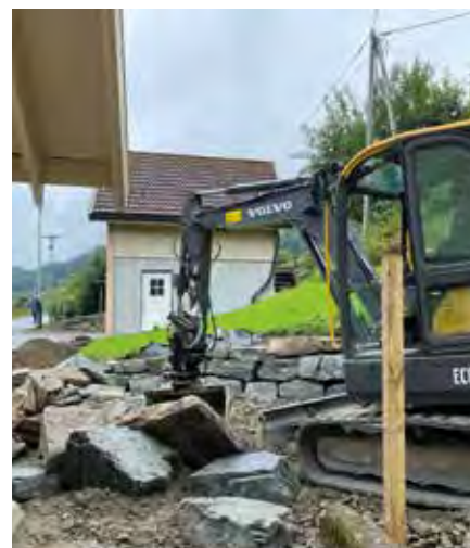
Lokal entreprenør i gang med å lage ny, flott mur langs den nye tilkomstvegen.
