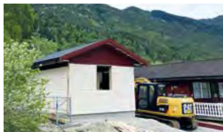
Nytt bygg for Orrhaug og Neshøgdi vassverk.
