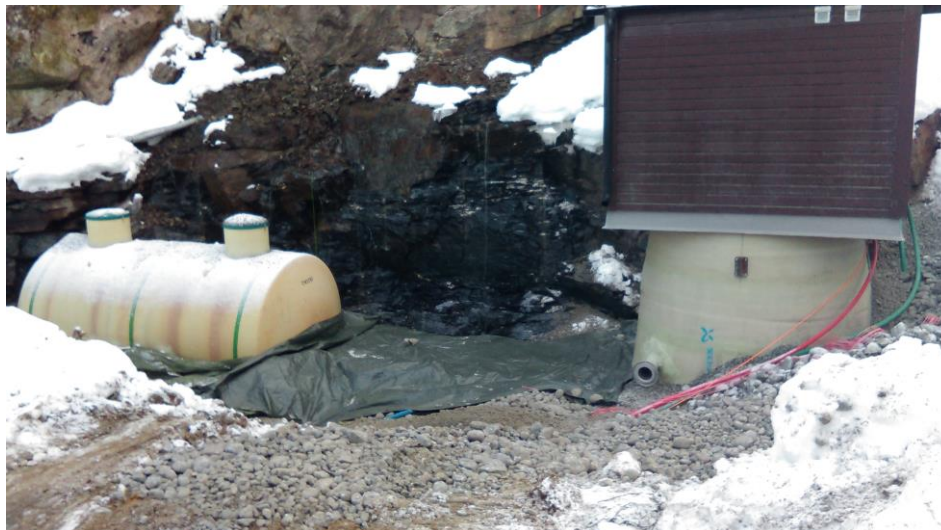
Bilete 1. Nedsetjing av ny pumpestasjon Lyngmo 2014.
